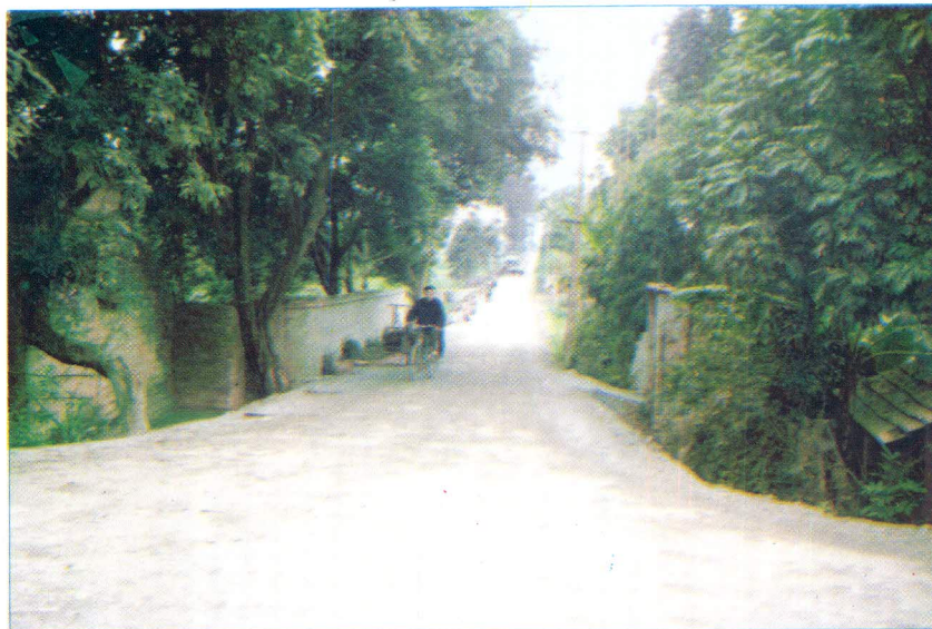
Đường trục đi qua UBND xã Liêm Chính, được nâng cấp, rải nhựa năm 2002.
